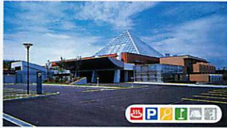
日帰り入浴もできる渤海温泉 公営ホテル シーサイドヴィラ渤海 志賀町
