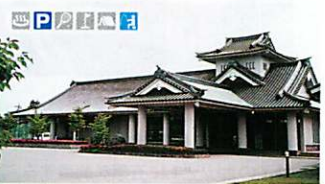
塩・ハーブミストサウナが好評 穴水町国民保養センター キャッスル真名井 穴水町
